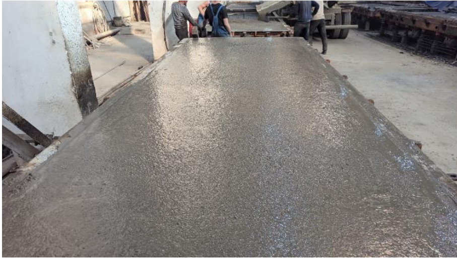
Рисунок 6.4 – Внешний вид уложенной бетонной смеси
