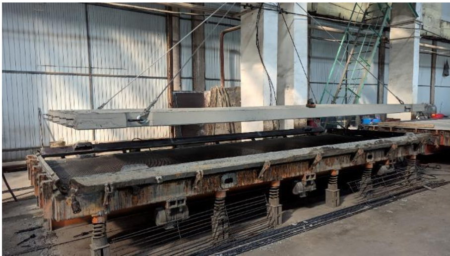
Рисунок 6.5 – Распалубка железобетонной плиты
