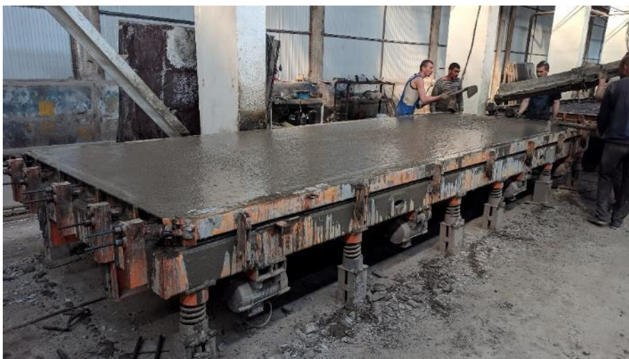
Рисунок 6.3 – Укладка самоуплотняющейся бетонной смеси
