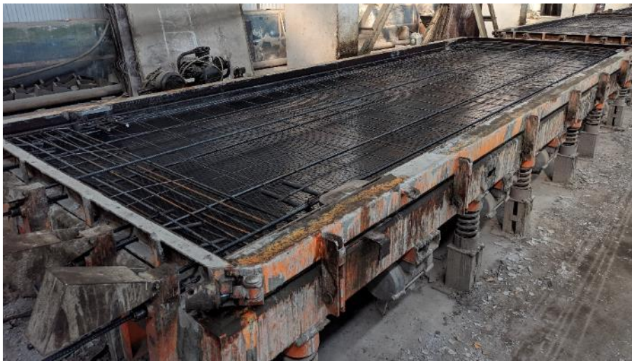
Рисунок 6.2 – Подготовка опалубки и армирования плиты
